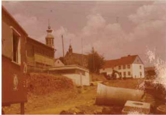
Abb. 3: Ausbau der Ortsdurchfahrt L 304, im Hintergrund die Kirche (Foto 1974)
