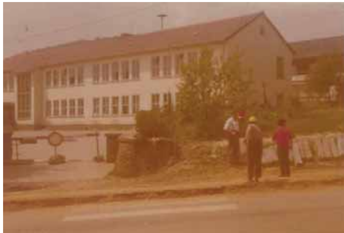
Abb. 4: Straßenbau, im Hintergrund die Schule
