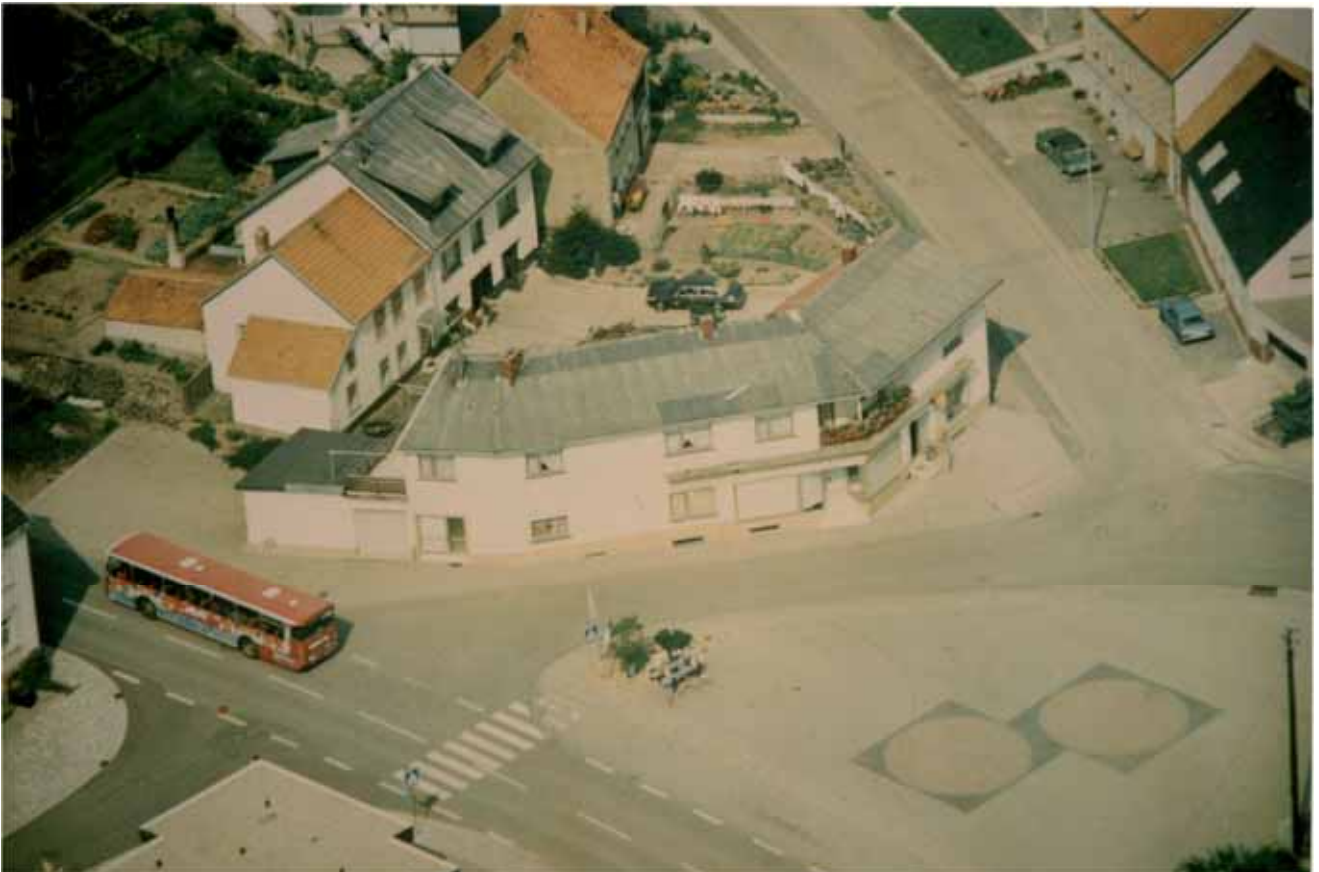
Abb. 6: Luftbild in Richtung Dorfplatz und des Anwesens von „Schäwersch Martin“ sowie der Häuser am Anfang der Straße zur Lehmkaul (Ortsarchiv)
