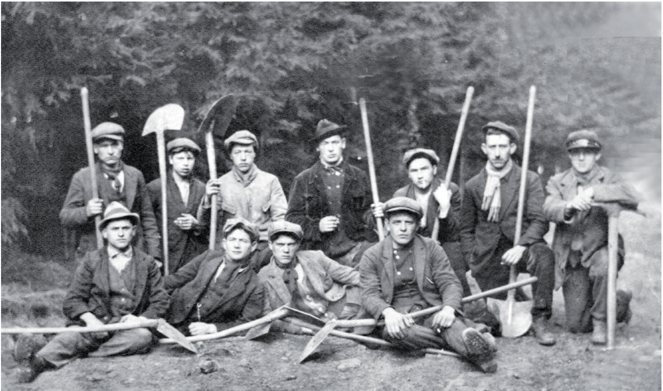
Abb. 11: Arbeitsgruppe beim Wasserleitungsbau in Dörsdorf im Jahre 1928
