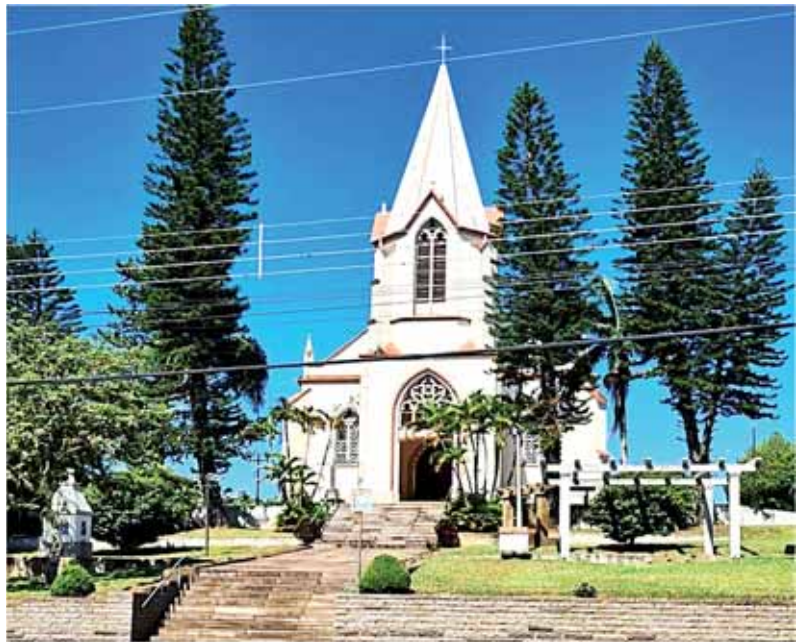
Abb. 30: aktuelles Foto der Kirche von São José do Hortêncio (2023)
