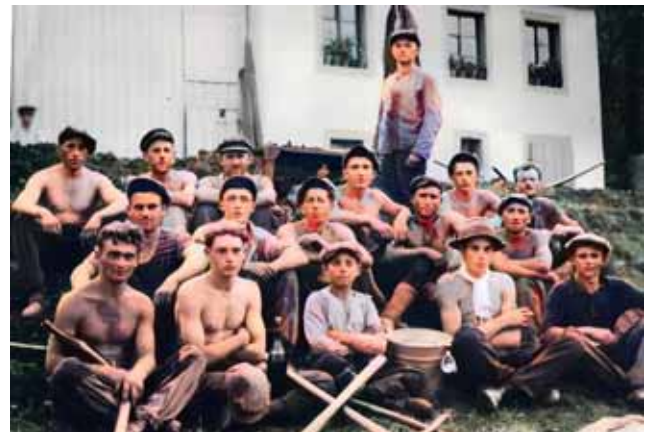
Abb. 4: Bau der Wasserleitung in Steinbach im Jahr 1928
