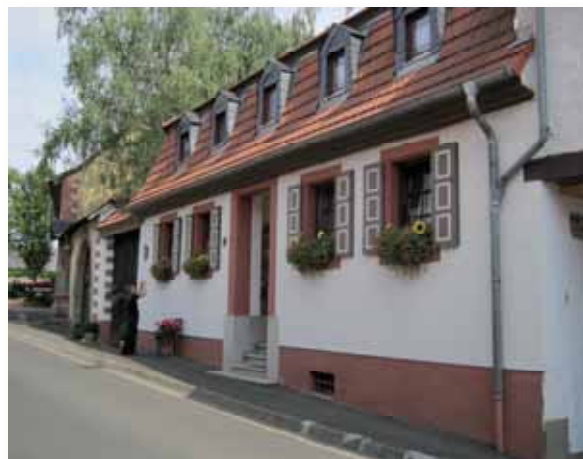
Abb. 2: Ehemaliges Kaplaneigebäude in Frei-Laubersheim
