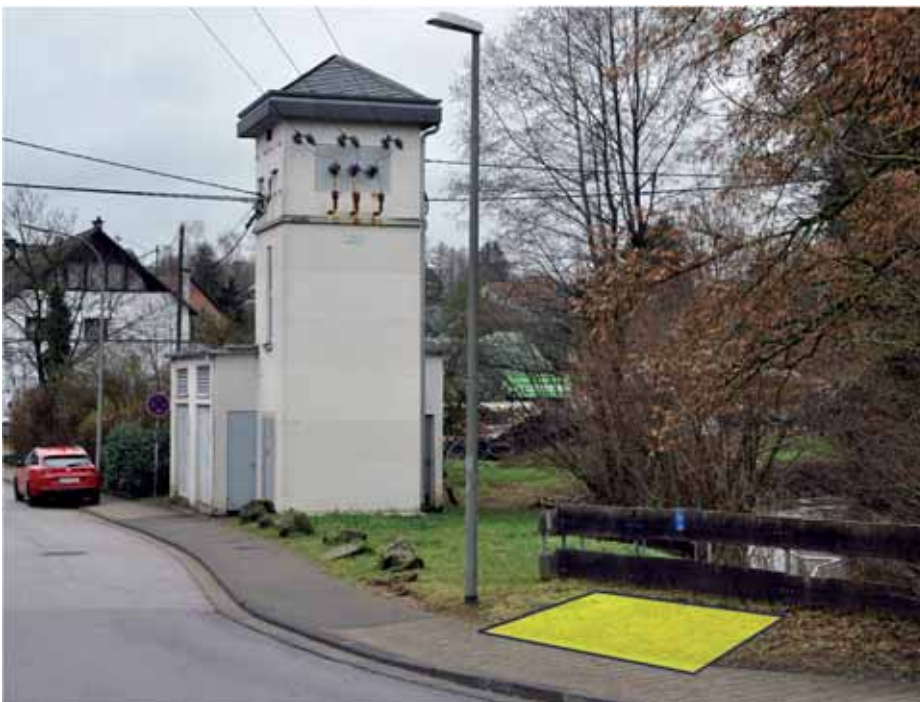
Abb. 19: Die fünf im Bauprogramm 1937/38 zum Neubau vorgesehenen Stationen im Leitungszug Wadern – Eppelborn sollten alle in der „Bauweise RWE-Betriebsverwaltung Trier“ aus Beton-Fertigplatten errichtet werden, wie die hier abgebildete Station in Thalexweiler. Die Fertig-Bauweise lässt sich an den im Abstand von 1,0 m verlaufenden horizontalen Fugen erkennen. Die lichten Innenmaße dieses Stationstyps betragen ca. 2,75 m x 2,75 m bei etwa 12 cm Wandstärke. Bei dem auf der linken Seite der Turmstation befindlichen Anbau handelt es sich nicht um einen Bestandteil der Turmstation, sondern um eine davon unabhängige und später errichtete Trafostation eines in der Nähe angesiedelten Gewerbebetriebes. Die alte Bügelstation befand sich auf der im Vordergrund gelb gekennzeichneten Fläche.
